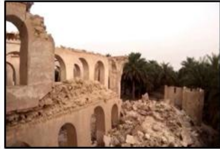
المصدر: الدراسة الميدانية صورة (٢٠): مباني متهدمة في حي الكوت فبراير ٢٠٢٠م
