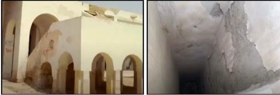
صورة (١٧) : تأثير الرطوبة الأرضية-عطي حوائط المقصورة قصر إبراهيم في حي الكوت، فبراير ٢٠٢٠م
